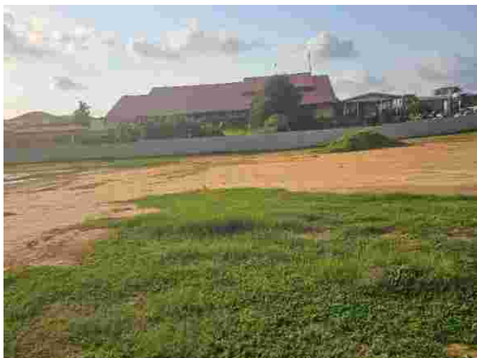
Photo 1 : Site de construction des nouveaux bâtiments
