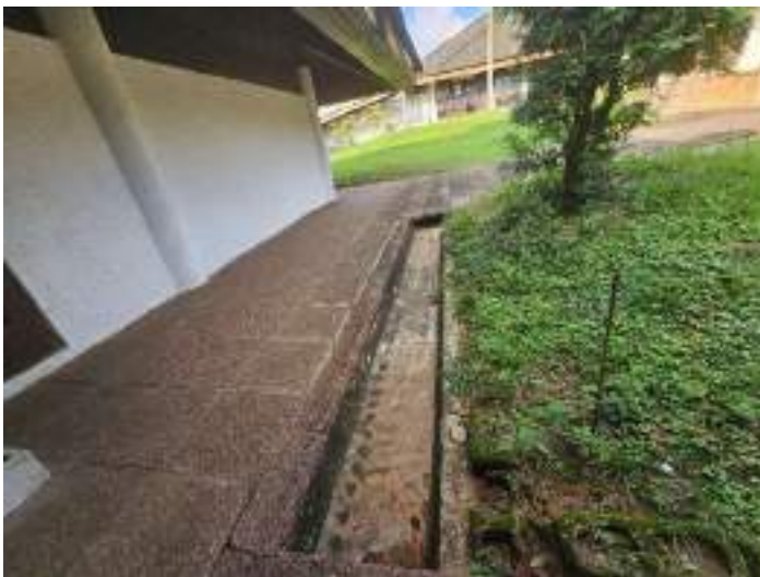
Photo 3 : Réseau de drainage des eaux pluviales
